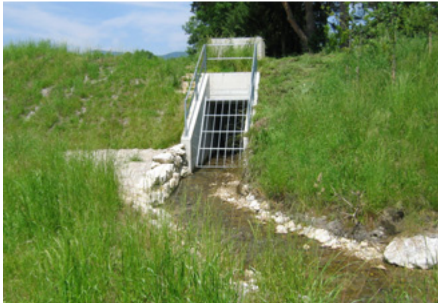
Abbildung 25: Mit einem Gitter gesicherte Eindolung
